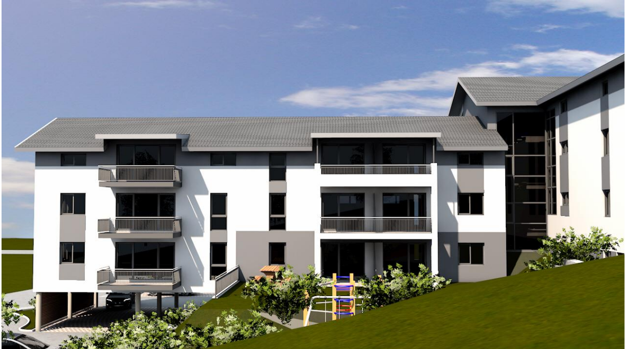
Ansicht von Westen
